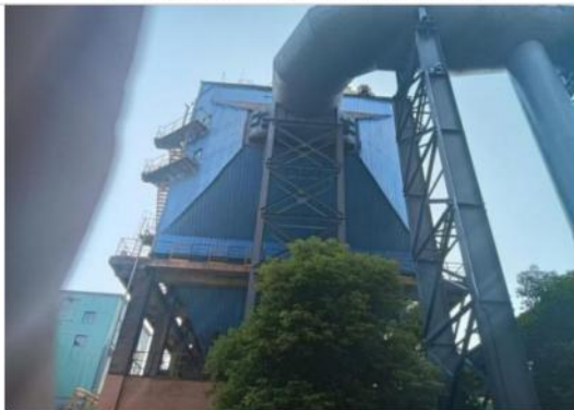
1#烧结机尾废气电袋复合除尘器
