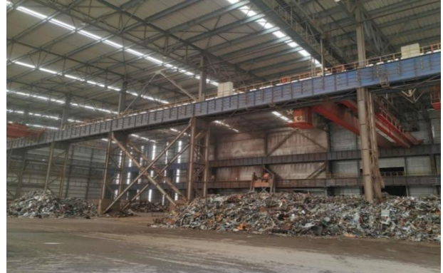
废钢堆存场地
