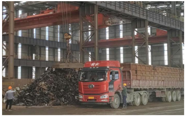
废钢卸车现场图
