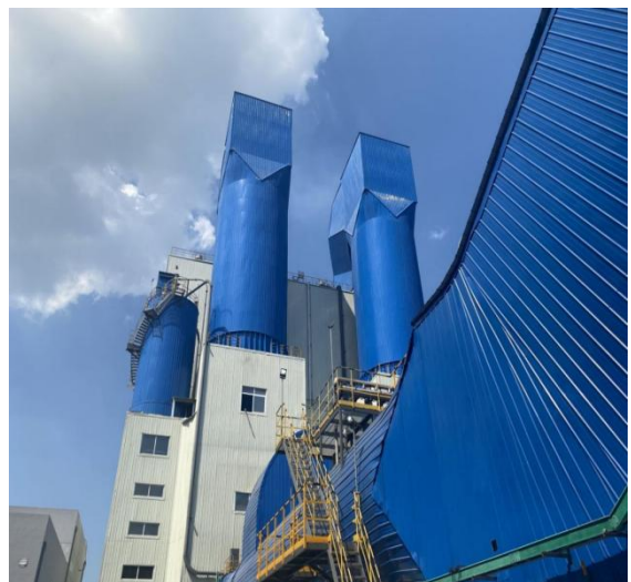
10、450 m 3 CFB 循环流化床干法脱硫
