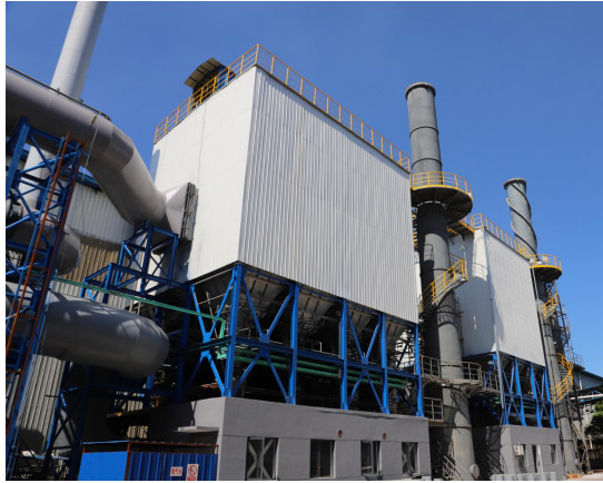
11、轧钢加热炉脱硫除尘
