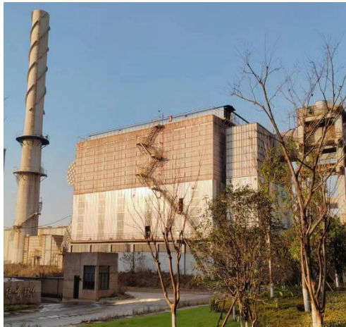
3、450 m 3 烧结机尾除尘
