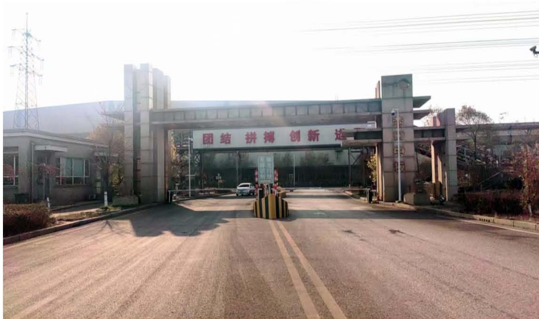
（上图为门禁系统和视频监控系统）
